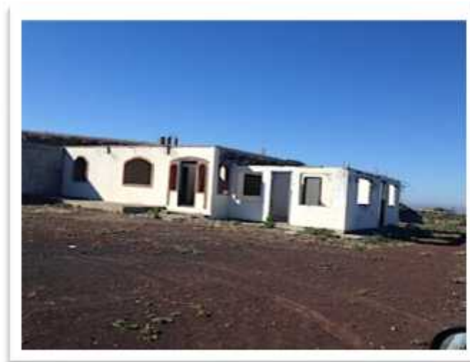
Imagen no. 10. De la construcciones actuales en predio.
